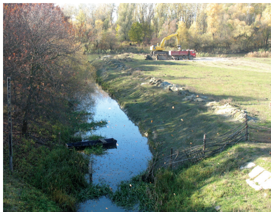
Изливни канал, до канала ДТД
