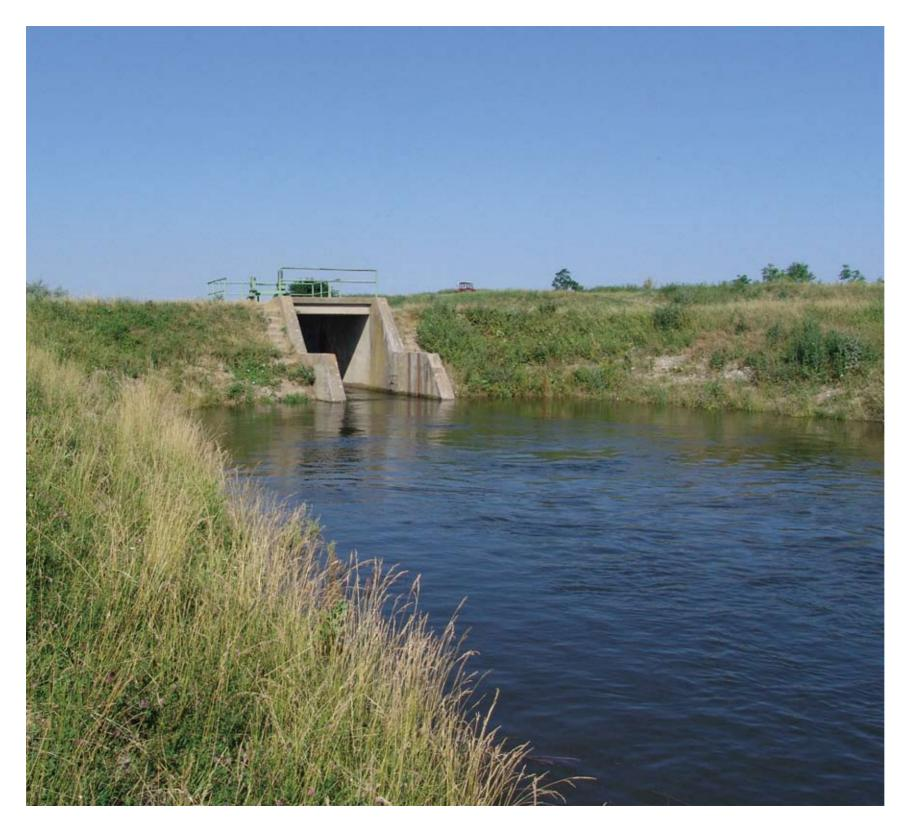
Устава Деспотово је изграђена 1961. год. на каналу Јегричка. Она омогућује упуштање воде из канала Нови Сад – Савино Село у Јегричку. Може да упусти до 15м³/сек воде. Има један отвор ширине 3 метра и дводелни табласти затварач, са механизмом за дизање на ручни погон.
