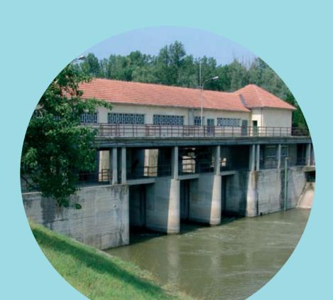
Устава Бездан је главна водозахватна устава бачког дела ХС ДТД. Налази се на најузводнијем делу Хидросистема, на споју Дунава и канала Пригревица-Бездан. Уставом се упушта вода из Дунава у ХС ДТД са протицајем до 60 м³/сеk. Грађење је почето 1958, а завршено 1960. године. Устава има три једнака отвора ширине од по 5 метара, са сегментним затварачима величине 5х4,2 метра.
