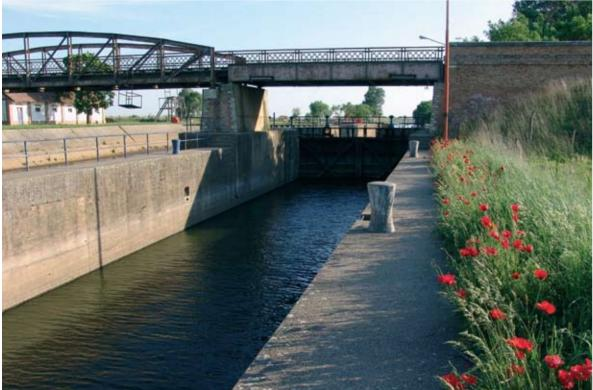
Преводница у Клеку је изграђена 1914. године и имала је једну комору за пролаз бродова. Доградњом и реконструкцијом 1969. године додата је још једна комора па је постала двостепена са три двокрилне капије. Стара комора је изграђена у неармираном бетону, а фундирана је на дрвеним шиповима. Дограђени део је од армираног бетона. Заједно са уставом део је хидрочвора Клек. Пројектована је за пловидбу бродова до 500 т носивости.
