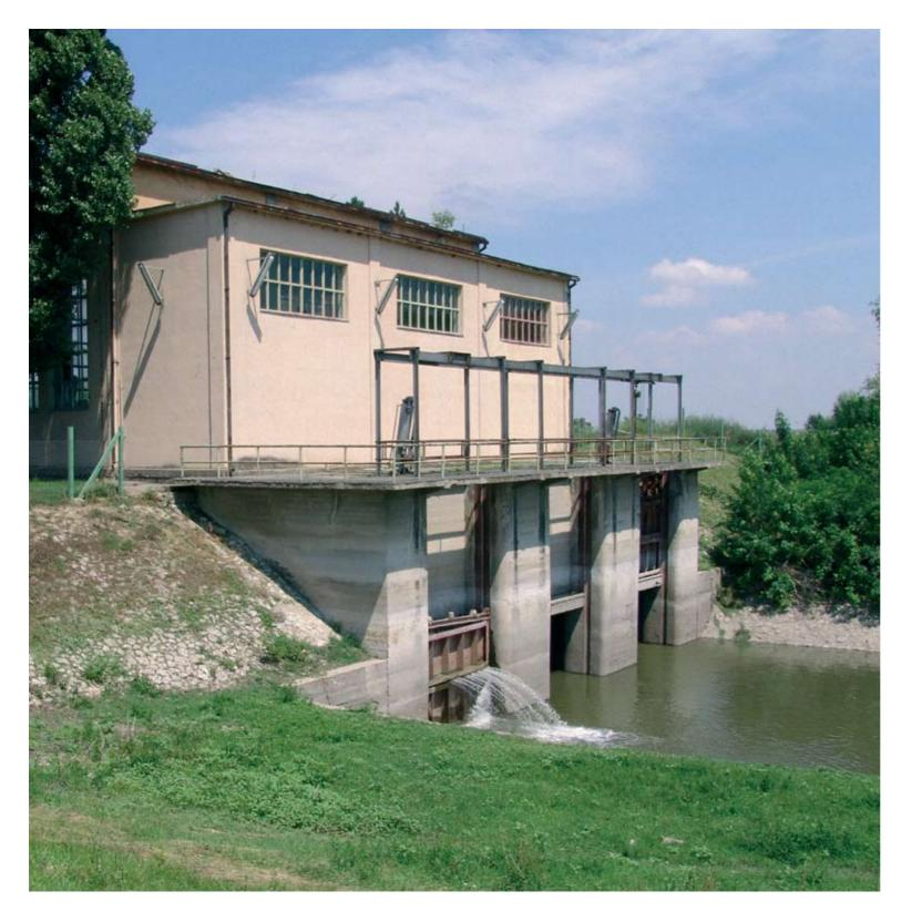
Изградња црпне станице завршена је 1963. године. Црпна станица Жабаљ се налази на пресеку канала Јегричка са тиским одбрамбеним насипом, на проширеном платоу насипа. Уграђена су два агрегата капацитета по 8 м³/сец. Служи за одвођење сувишних вода из каналске мреже ХС ДТД у Тису. При ниским водостајима Тисе омогуђује и гравитационо испуштање.
