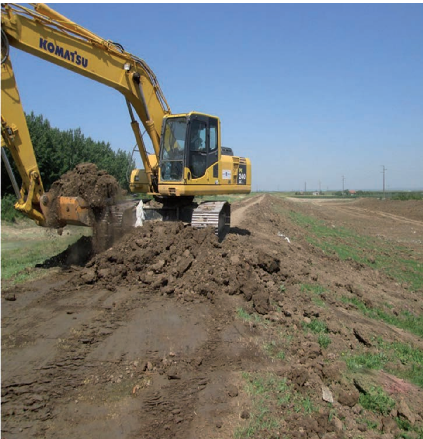
Градња привременог насипа код Лађарка
